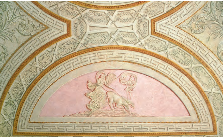
Die Räume der Beletage sind aufs Beste restauriert ...
