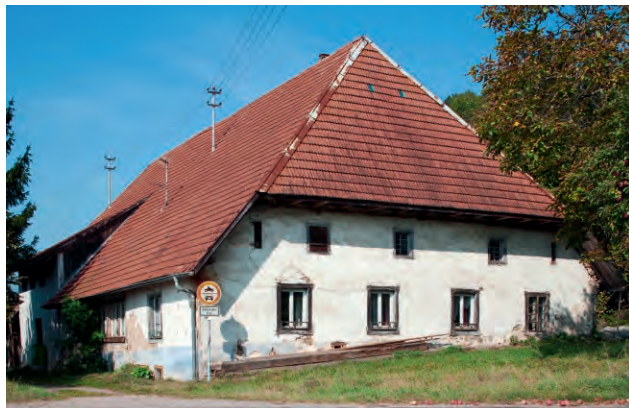
Murg, Zechenwihler Hotzenhaus
