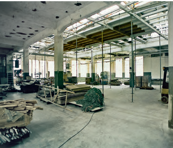
Rottweil, Neckartal, Werkstattgebäude
