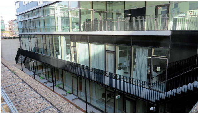
Bild 3: Beispiel für zwei Untergeschosse im neuen Radiologiezentrum des DKFZ, die bei der BGF, aber nicht bei der GF mitgezählt werden
